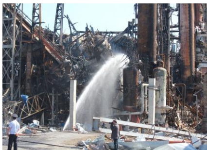
Рисунок 1 – Разрушения на Ачинском НПЗ
