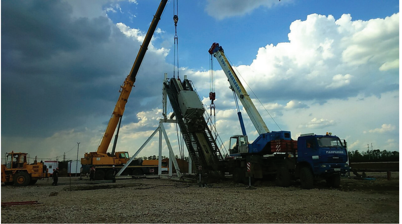
Рисунок 1.8 – Современная буровая установка для ГНБ
