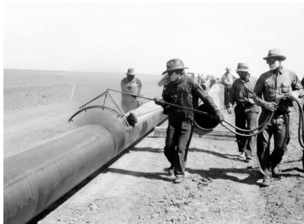
Рисунок 5 – Бригада рабочих компании «Bechtel» применяет новую технологию нанесения изоляции прямо на трассе трубопровода Техас-Чикаго (1930 год)
