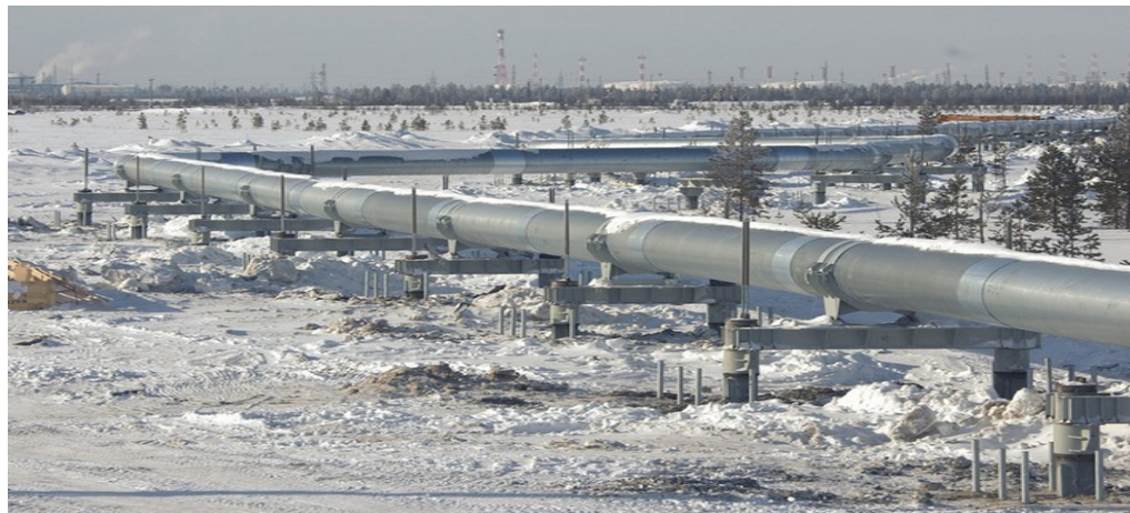
Рисунок 13 – Участок трубопровода «Заполярье-Пурпе», размещенный на опорах
