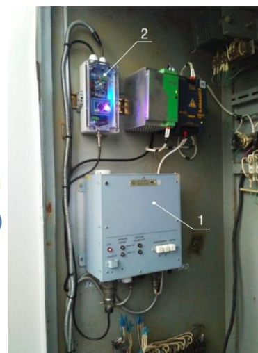
1 – блок преобразования сигнала БЭ-38 (в составе ИВД-ПФ-5МТ); 2 – БСА Рисунок 2 – Прототип (а) и опытный образец БСА (б) интегрированный в штатную систему виброконтроля САУиР ГПА ст. № 33 КС-19А «Шаран»
