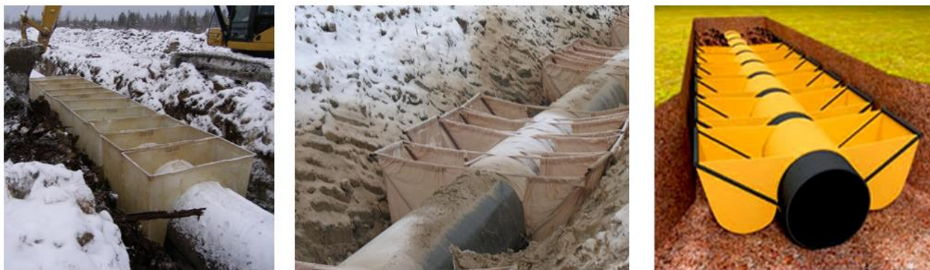
Рисунок 3.11 – Точечное закрепление трубопроводов привозным грунтом
