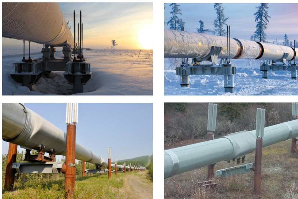
Рисунок 1.5 – Надземная укладка на опорах в сейсмически активных северных районах с мерзлыми и сезонно-талыми грунтами
