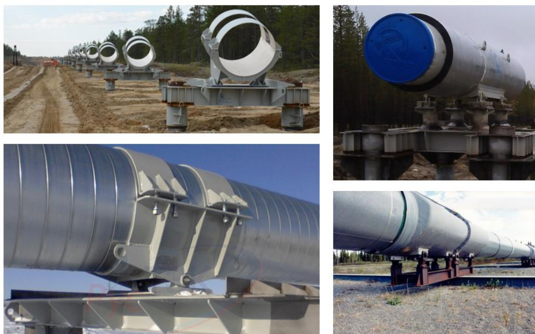
Рисунок 1.8 – Укладка на опорах в многолетнемерзлых грунтах
