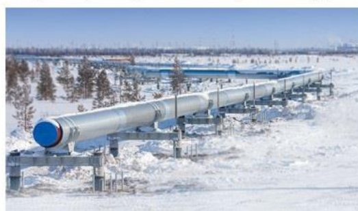
Нефтепровод «Заполярье – Пурпе»
