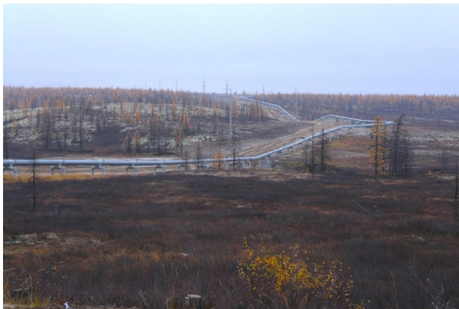
Рисунок 1.10 – Участок трубопровода «Заполярье-Пурпе» - пример прокладки трубопровода в многолетнемерзлых грунтах
