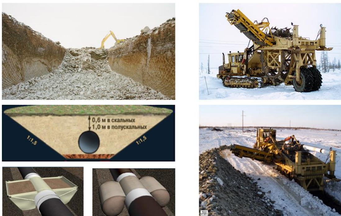
Рисунок 1.9 – Подземная сейсмостойкая прокладка в широких траншеях
