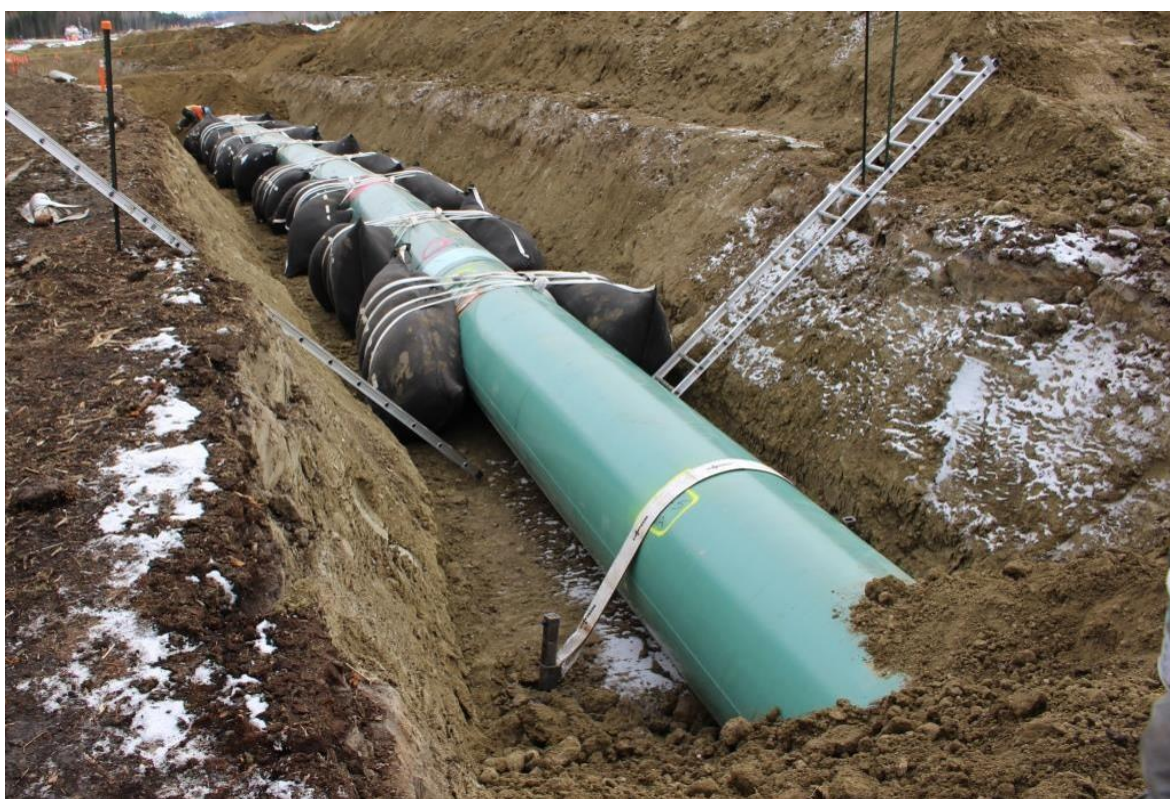
Рисунок 3.14 –Применение геотекстильных утяжелителей
