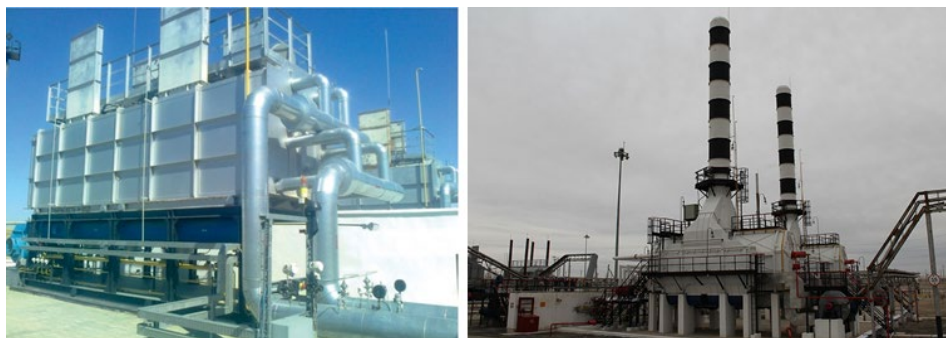
Рисунок 19 – Отечественные печи подогрева нефти для промышленной подготовки и трубопроводного транспорта (слева – ПТБ-10; справа – Г9П02В)
