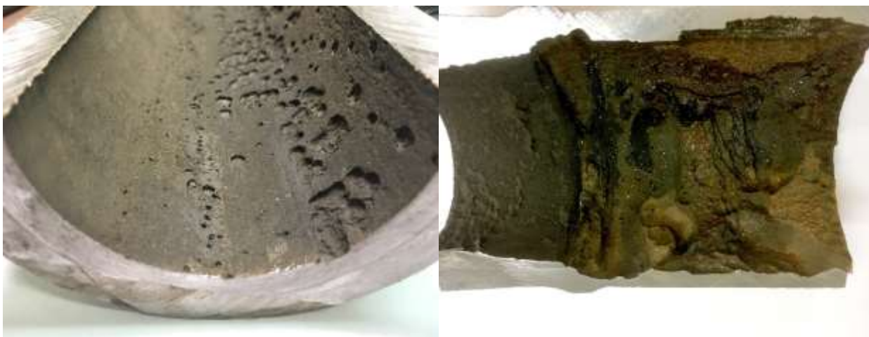
Рисунок 1 – Примеры протекания углекислотной коррозии внутренней поверхности газопромыслового оборудования и трубопроводов
