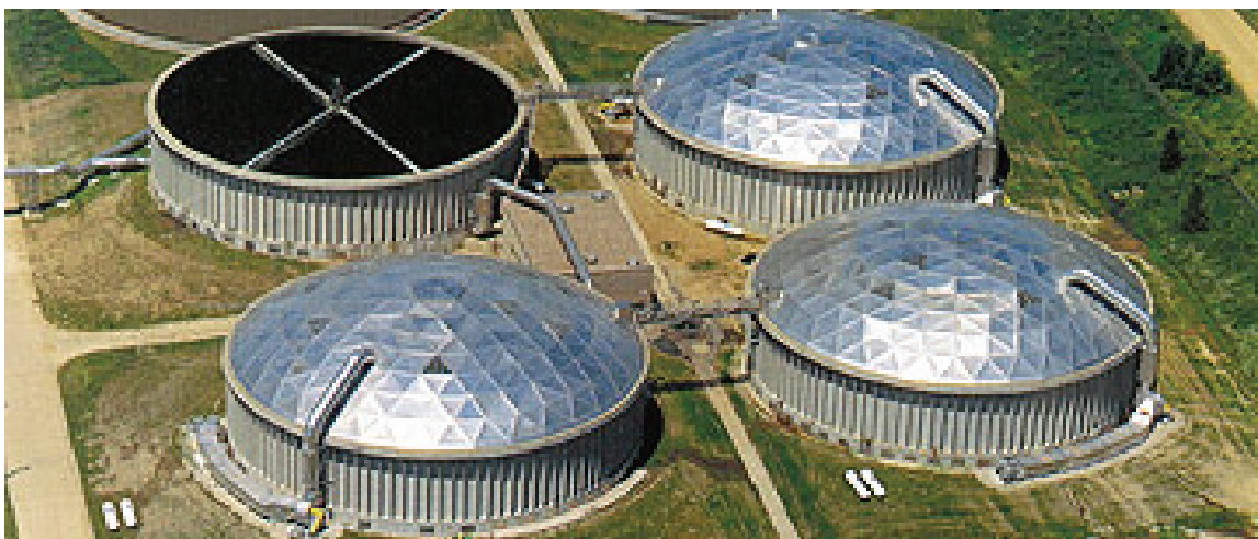
Рисунок 4.11 – Алюминиевая купольная крыша, изготовленная фирмой «Ultradome» для НПЗ в Одессе
