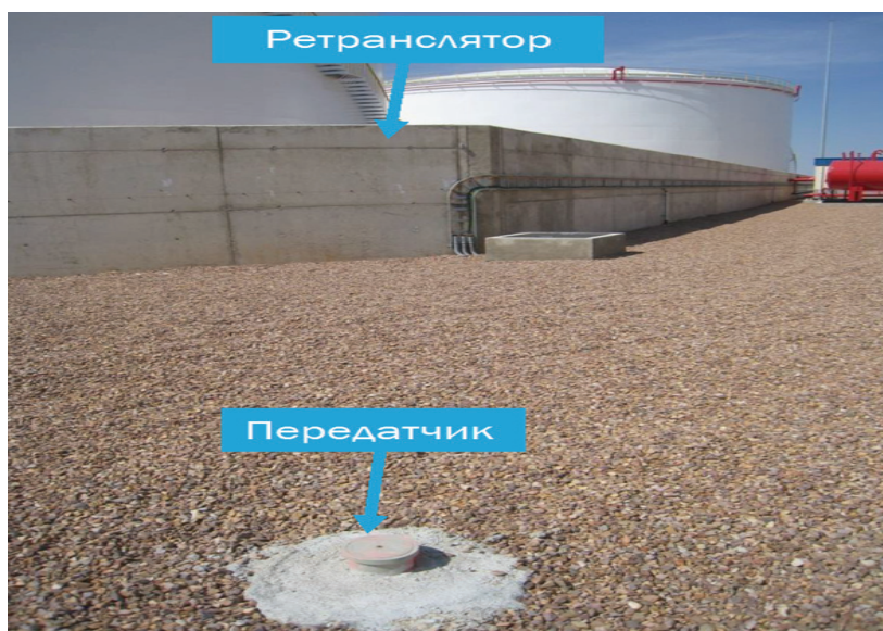
Рисунок 5.11 – Общий вид контрольной скважины
