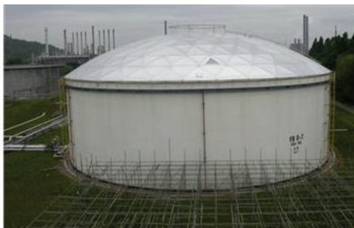
Рисунок 4.12 – Алюминиевая купольная крыша компании «Vasopo» в сборе
