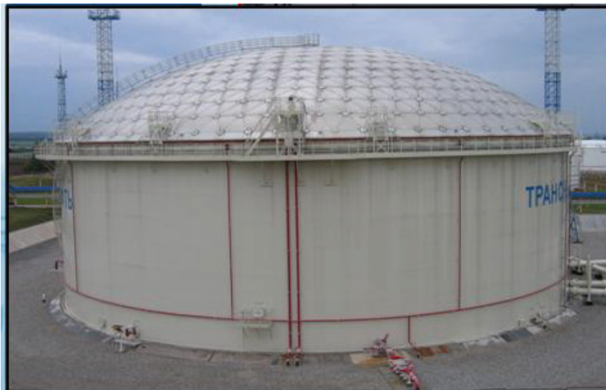
Рисунок 4.5 – Общий вид резервуара с купольной крышей
