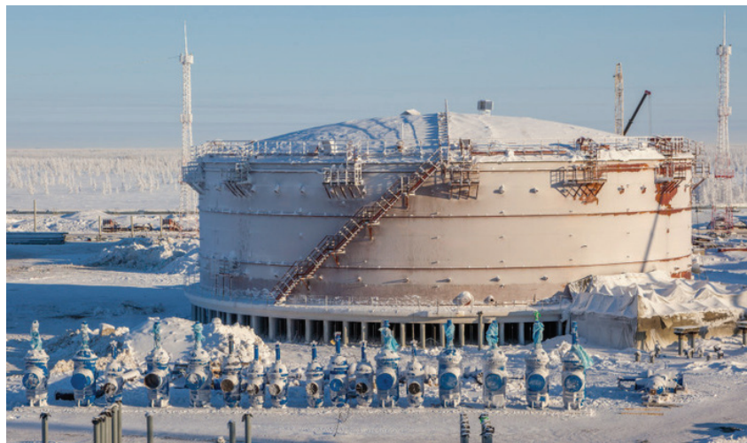
Рисунок 1.20 – Общий вид резервуара на сваях
