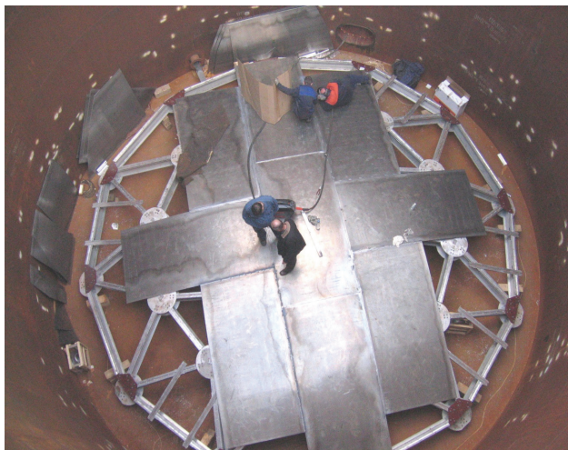
Рисунок 4.8 – Герметичная алюминиевая купольная крыша по проекту ЗАО «Нефтемонтаждиagnostика»
