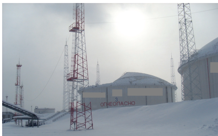
Рисунок 4.19 – Общий вид резервуара с разрушенной крышей
