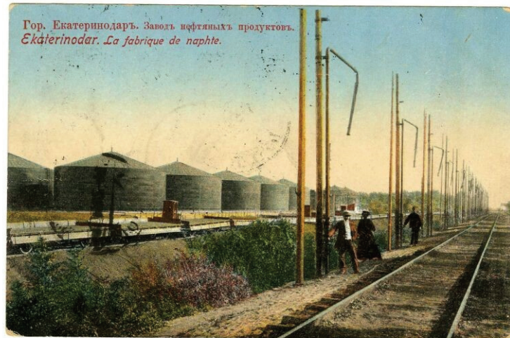
Рисунок 1.5 – Резервуарный парк в г. Краснодар
