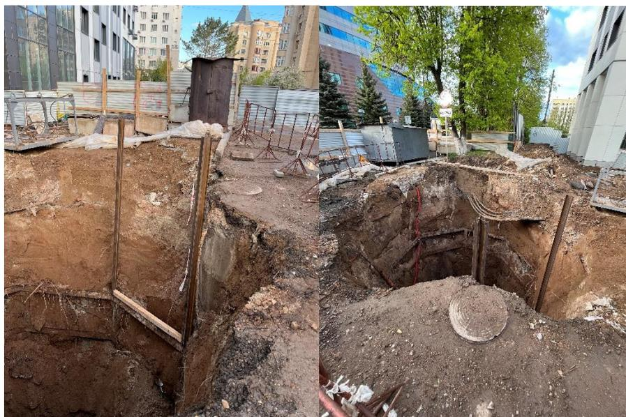
Рисунок 2 – Внешний вид обрушившегося шахтного колодца канализационного коллектора в городе Уфе (08.04.2022)
