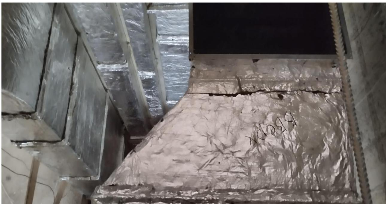
Рисунок – Внешний вид теплоизолированных воздуховодов с герметизацией швов
