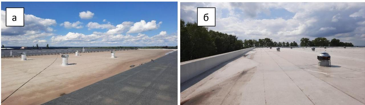
Рисунок 1- Общий вид кровли из ТПО мембраны
