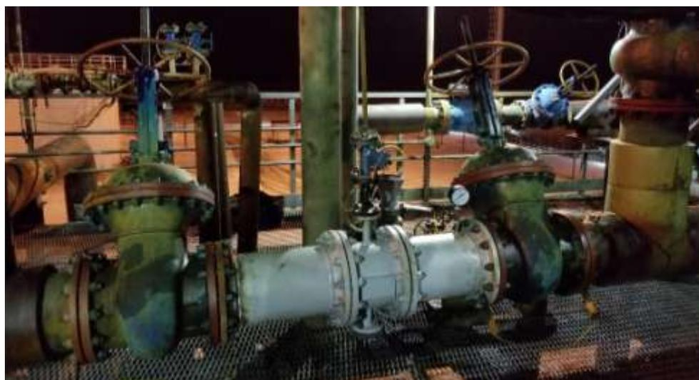
Рисунок 4.18– Фото смесителя для поглотителя сероводорода
