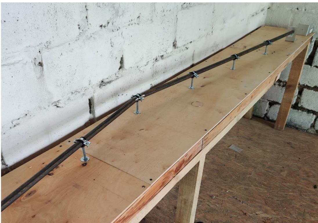
Рисунок 3.3 – Укладка зигзагообразного участка трубы на опоры
