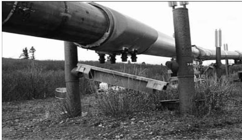
Рис. 1. Потеря устойчивости термоопор по трассе трубопровода
