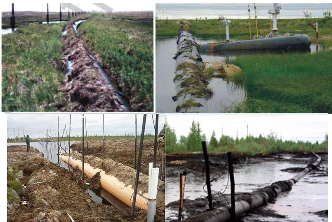
Рисунок 1.7 – Случаи потери проектного положения трубопровода
