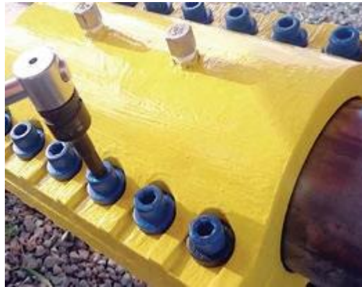
Рисунок 1.8 – Метод ремонта с применением композитно-муфтовой технологии [4]
