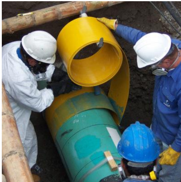
Рисунок 1.12 – Ремонт с помощью системы типа Clock Spring [41]
