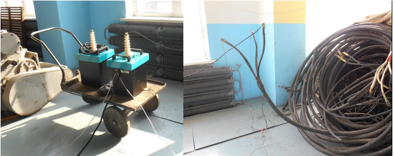
Рисунок 3.12 – Процесс выполнения испытаний
