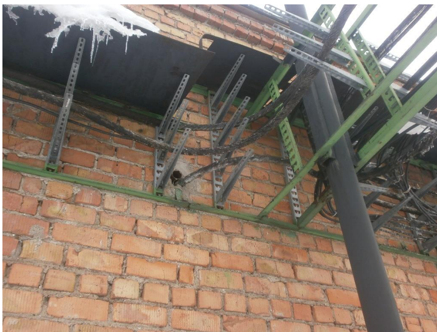
Рисунок 1.5 – Расположение кабелей на предприятии
