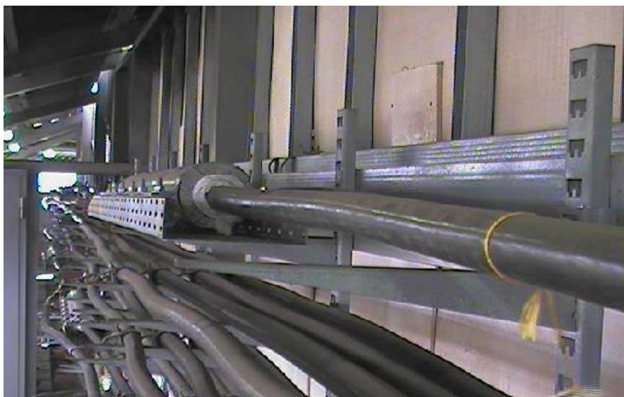
Рисунок 1.4 – Соединение кабельных линий муфтами
