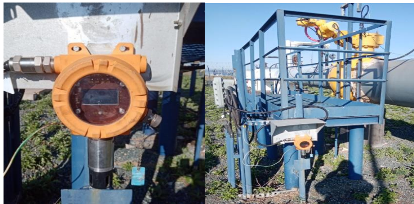
Рисунок 4.9 – Газоанализатор ССС–903М
