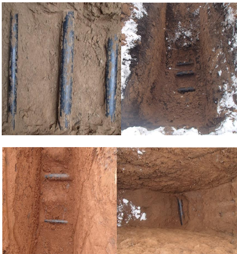
Рисунок 4.5 – Диагностирование промышленных трубопроводов
