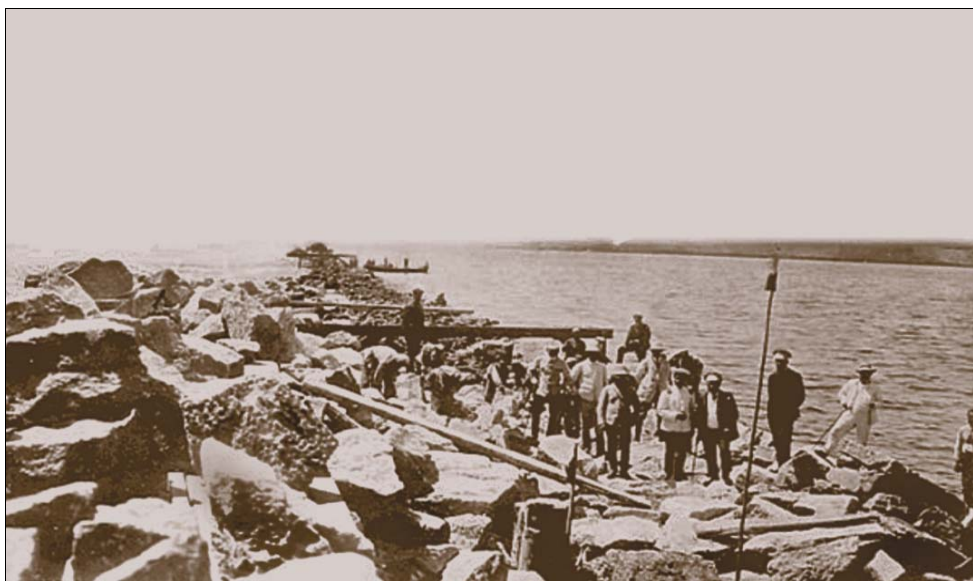
Рисунок 2.10 – Засыпка Биби-Эйбатской бухты. Начало укладки
