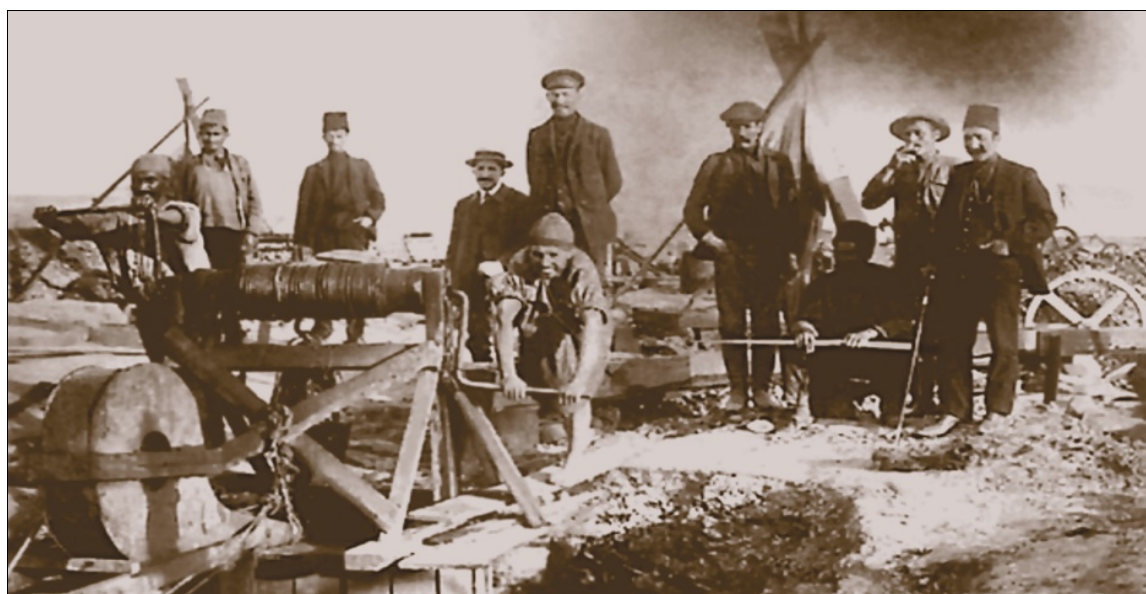
Рисунок 2.3 – Колодезная добыча нефти в Бакинских промыслах
