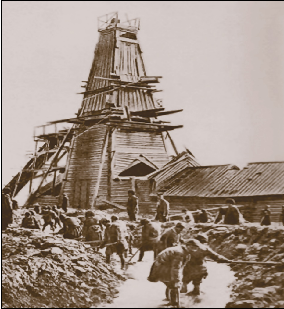
Рисунок 2.7 – Колодезная добыча нефти в Баку
