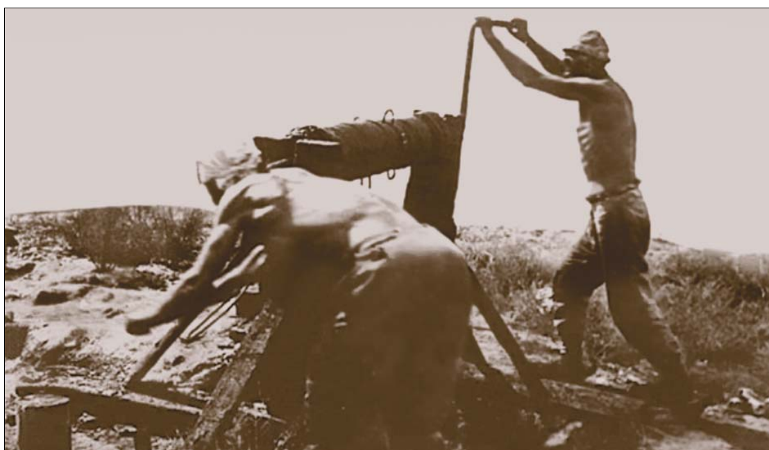
Рисунок 2.2 – Добыча нефти колодезным способом
