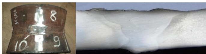
Рисунок 2 – Переход с дефектным сварным швом, вырезки из трубопровода в точке подключения газопровода Ду 300 технологической линии к газопроводу внешнего транспорта газа Ду 500
