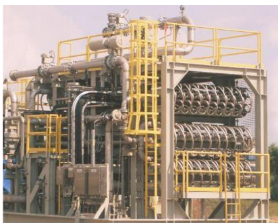
Рисунок 1.3 – Один из семи модулей для сепарирования сульфатов, способный производить 350,000 баррелей морской воды с низким содержанием сульфат ионов для Kizomba A месторождения в Западной Африке
