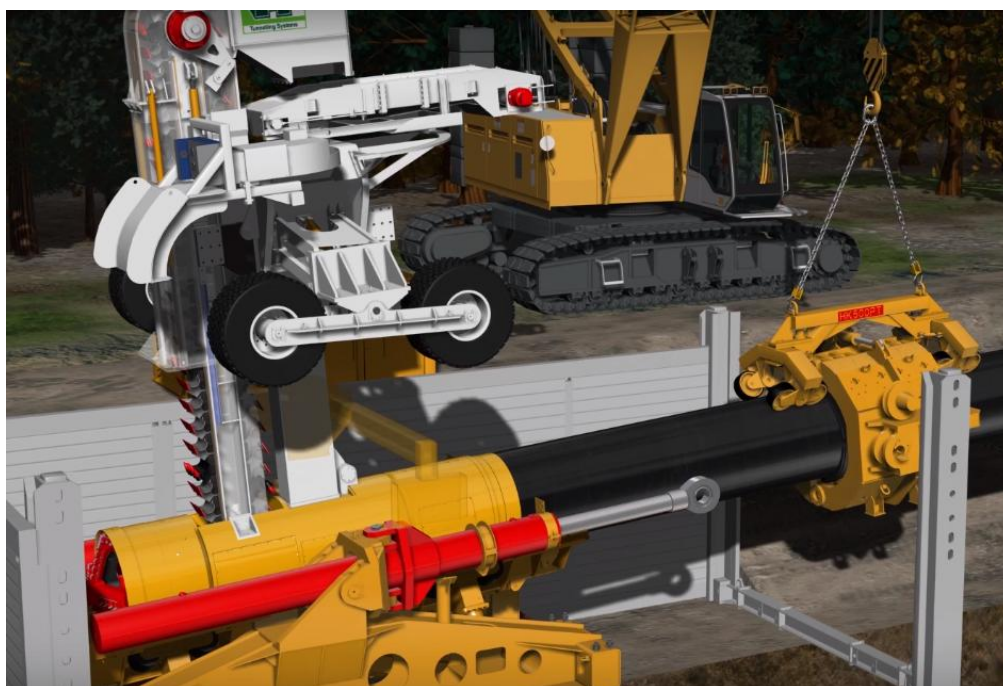
Рисунок 2 – Процесс установки бурильной машины
