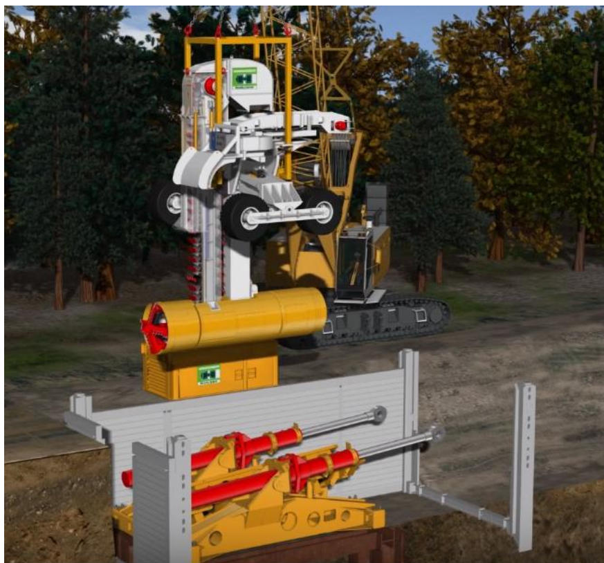
Рисунок 1 – Процесс подъёма бурильной машины
