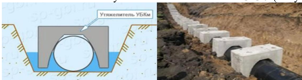
Рисунок 3- Утяжелители УБКм
