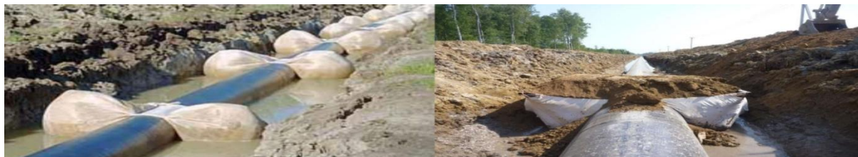
Рисунок 2- Балластировка утяжелителями типа КТ-300Т
