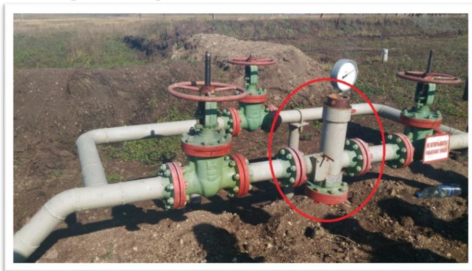
Рисунок 1- Пример вертикальной камеры пуска шаров, не приспособленной для внутритрубой диагностики
