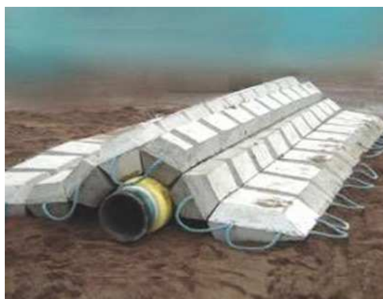
Рисунок 2 – Защита подводного трубопровода при помощи железобетонных фартуков
