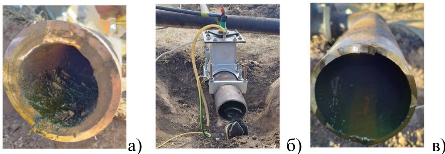
Рисунок 2 – Опытно-промысловые испытания установки ЭГДУ-ТО. Роснефть-Грознефтегаз, г. Грозный. Удаление ТСО/АСПО из промыслового нефтепровода диам. 114 мм: а – ТСО/АСПО в нефтепроводе; б – работа оснастки установки ЭГДУ-ТО в момент удаления ТСО; в – нефтепровод после обработки
