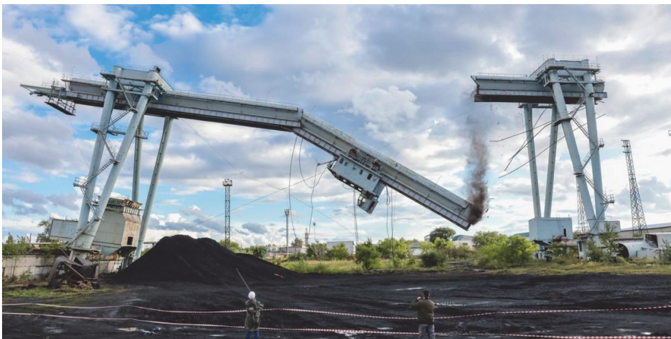
Рисунок 2. Фотография демонтируемого лазерным излучением крана-перезружателя [2]
