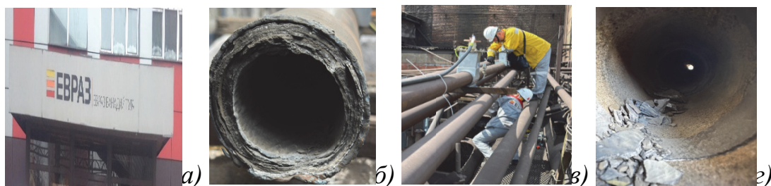
Рисунок 2. Удаление ТСО на АО «ЕВРАЗ-Ванадий» Тула. Участок трубопровода эстакады шламопровода от газоочистки печей плавки. а) ЕВРАЗ-Ванадий Тула; б) – трубопровод с ТСО; в) – установка оснастки; г) – трубопровод после удаления ТСО.
