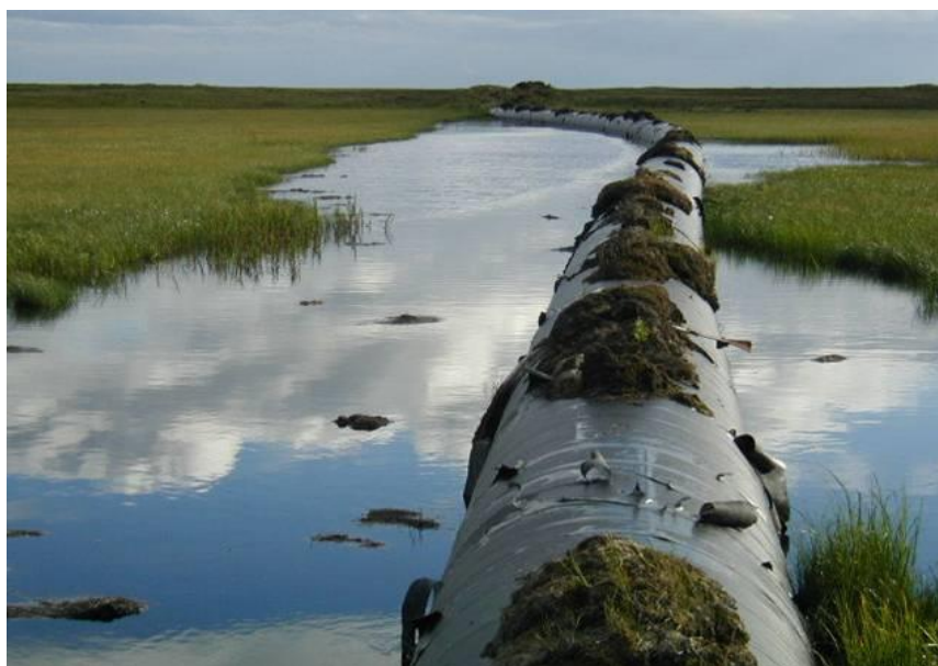
Рисунок 1.17 – Всплывший трубопровод
