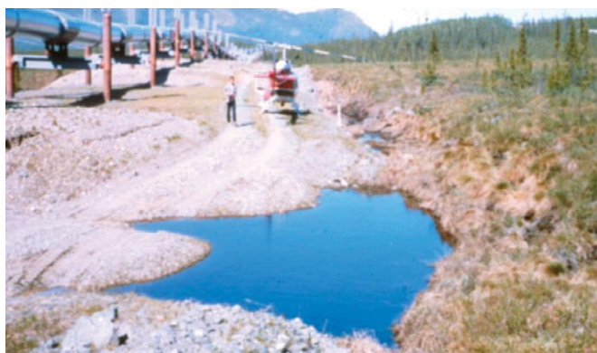
Рисунок 1.7 – Увеличение площади термокарста на технологической дороге Трансаляскинского нефтепровода [22]
