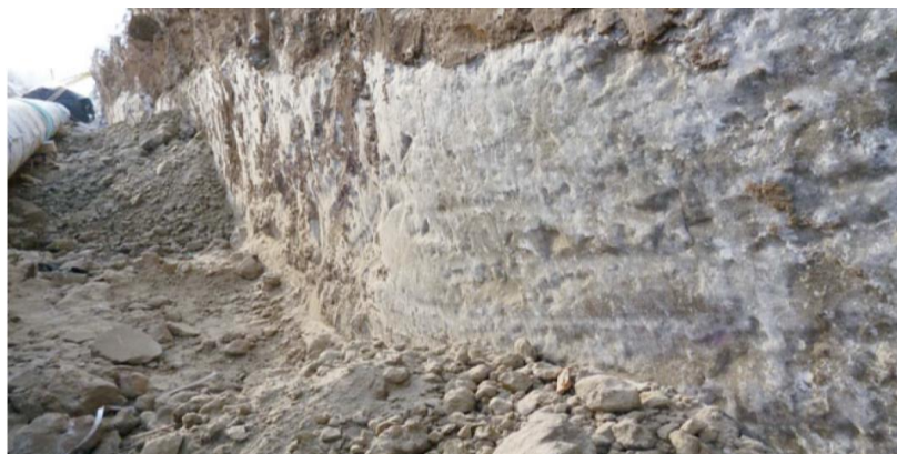
Рисунок 1.6 – Ледогрунтовая стенка траншеи подземного нефтепровода ВСТО диаметром 1040 мм (март 2014 г.) [22]
