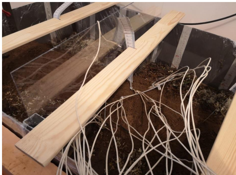
Рисунок 4.3 - Измерение положения оси трубопровода
