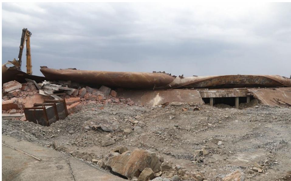
Рисунок 1.20 - Аварийный резервуар РВС-30000 № 5, ставший причиной разлива нефтепродуктов в Норильске
