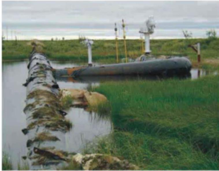
Рисунок 1.3 – Всплытие трубы на участке трассы [166]
