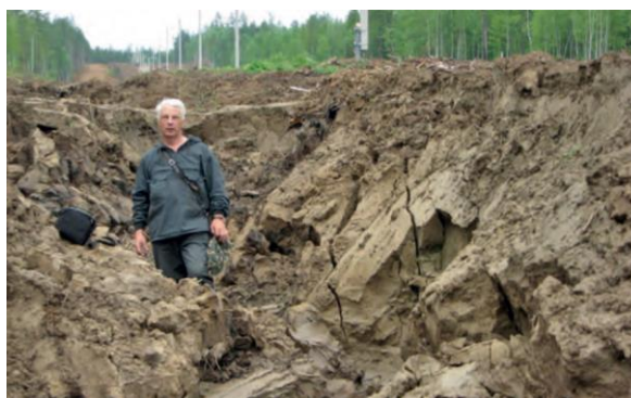
Рисунок 1.2 – Активная термоэрозия в средней части магистрального газопровода «Сила Сибири», 2011 г. [189]
