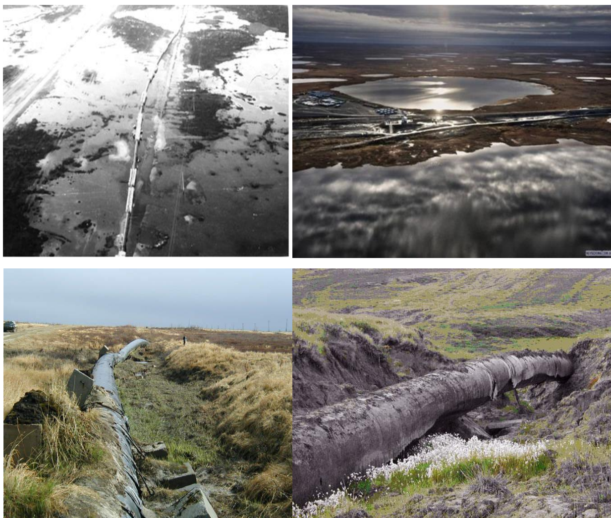
Рисунок 1.16 – Арочное выпирание подземных трубопроводов
