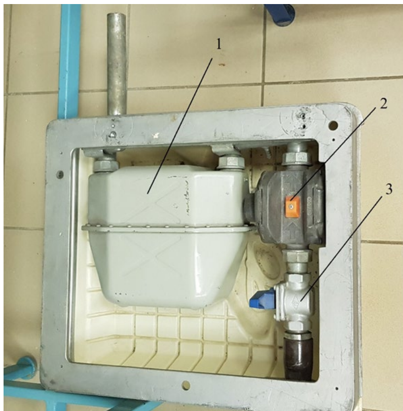
Рисунок 1.37 – Домовой газорегуляторный пункт (ДГРП)
