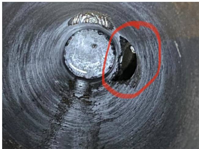
Рисунок 3.4 – Профрезерованное «окно» в ОК
