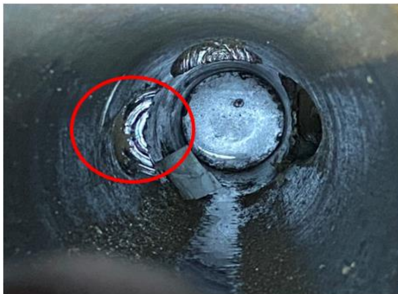
Рисунок 3.14 – Профрезерованное «окно» в ОК
