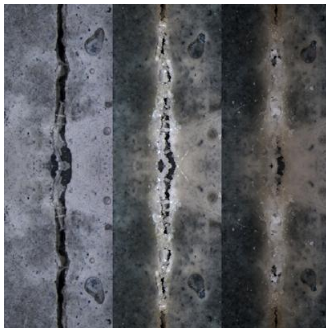
Рисунок 1 – Процесс самовосстановления бетона
