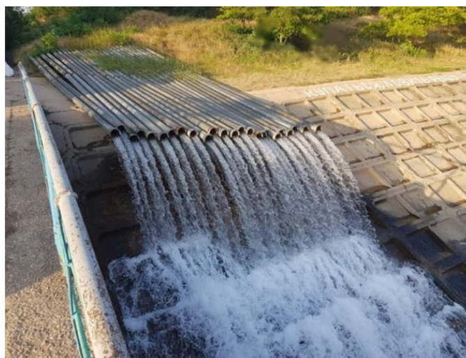
Рисунок 1.24 – Подача воды по ПМТ в Северо-Крымского канала
