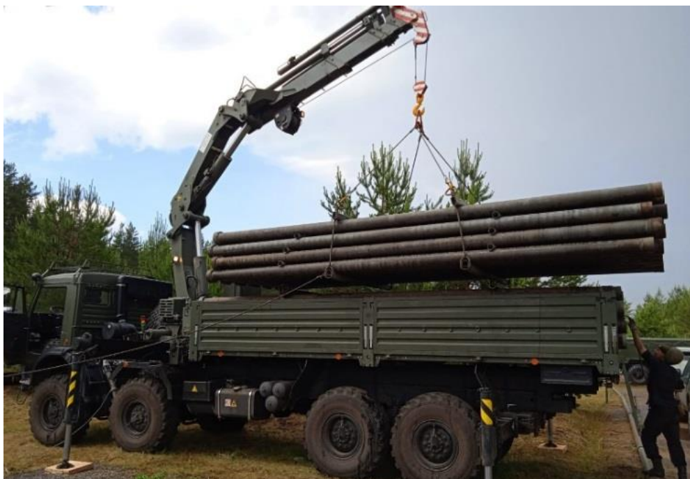
Рисунок 4.7 – Погрузка труб на автомобиль-трубовоз КМВ-20К
