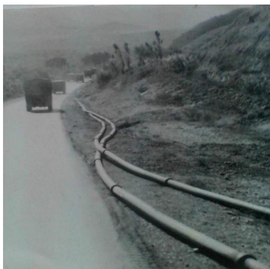
Рисунок 1.17 – Две линии трубопровода проложены вдоль дороги
