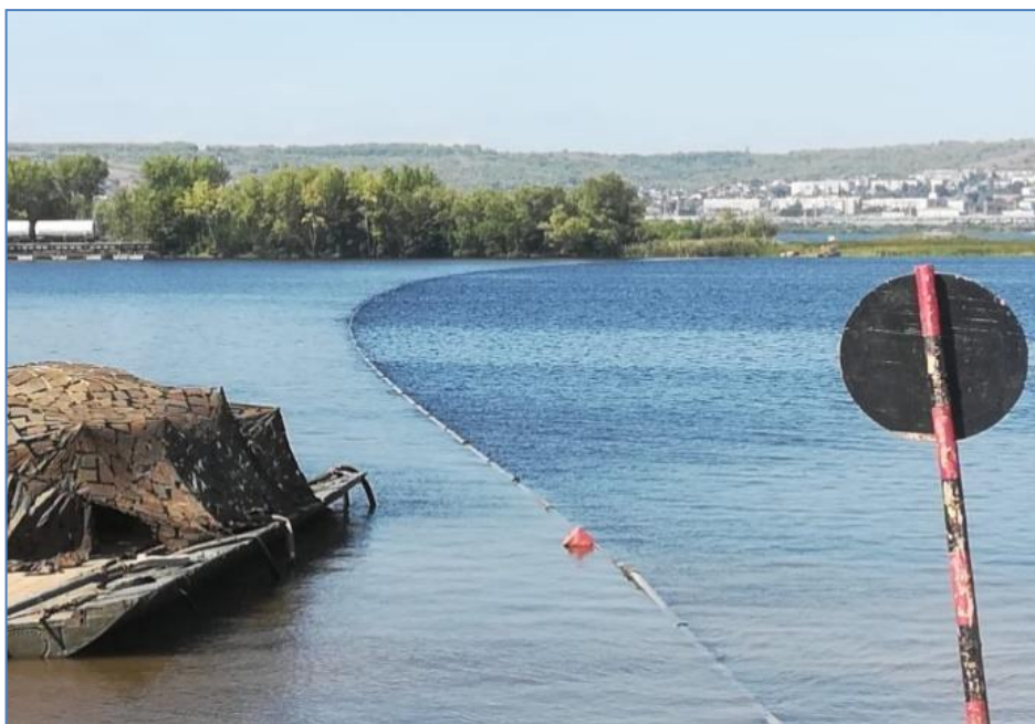
Рисунок 1.26 – Развертывание трубопровода ПМТП-150 через р. Волга
