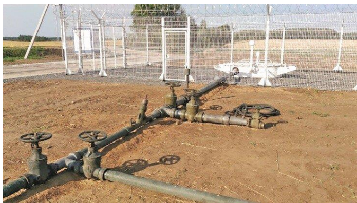
Рисунок 1.21 – Подключение ПМТ к МНПП через специальный колодец
