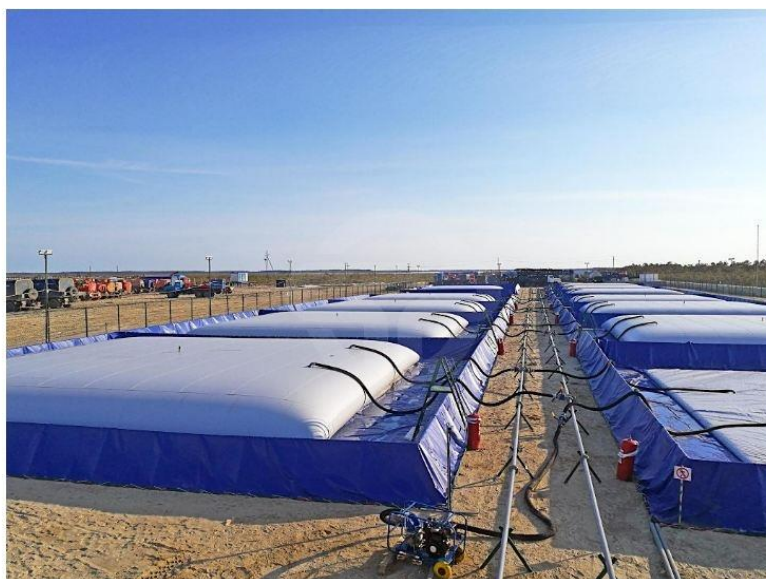
Рисунок 4.11 – Полевой склад горючего из эластичных резервуаров
